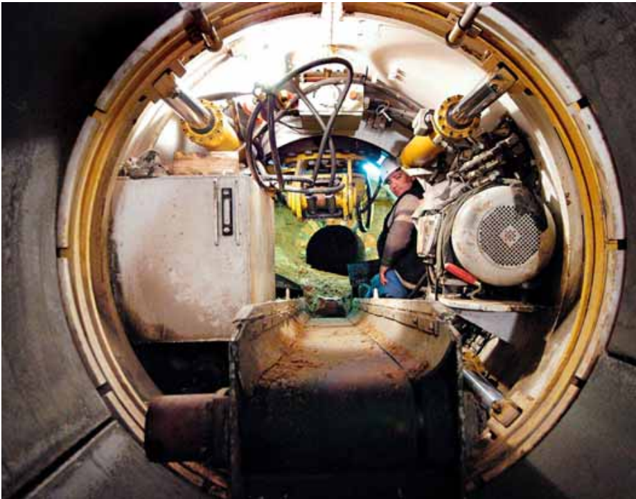
Wie beim Großtunnelbau befindet sich beim Mini-Tunnel-System von Tauber die gesamte Technik von Vortriebshydraulik, Steuercockpit über Transporteinrichtungen und Abbaugeräten in einer Metallröhre.
