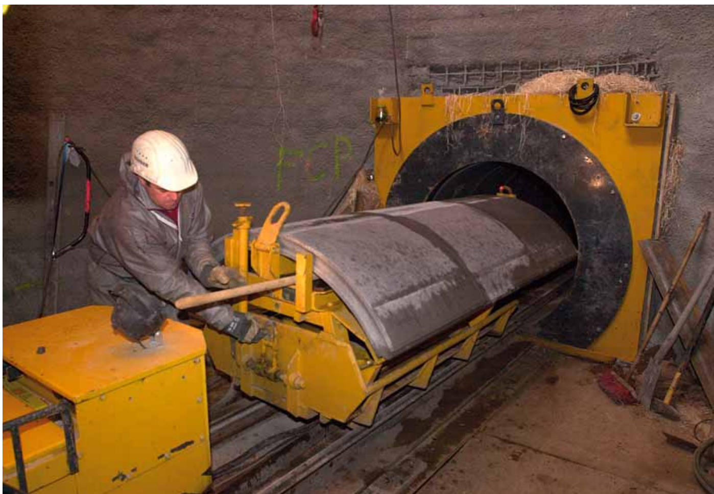
Für Anfahr- und Kopfschächte wird eine Baugrube von zirka 3,80 Metern Durchmesser benötigt, auch über dem Schacht sind nur geringe Stellflächen notwendig.
