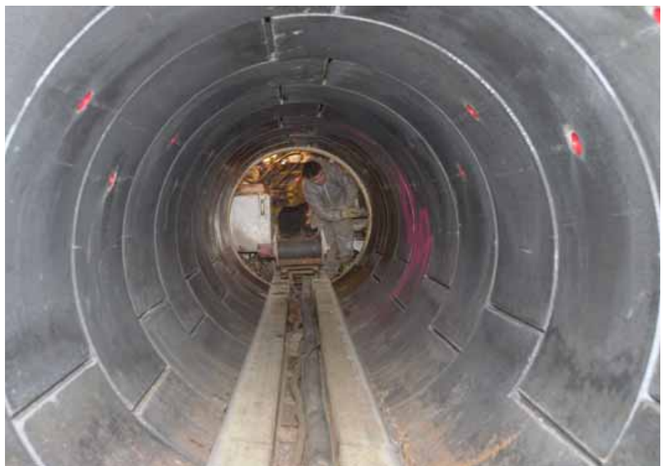
Die Tübbings setzen sich aus drei Betonteilen zusammen, welche mittels axial angeformter Nut und Feder einen Ring formen und versatzfrei zum voran liegenden Rohrring anschließen. | Fotos: Tauber Rohrbau GmbH u. Co. KG
